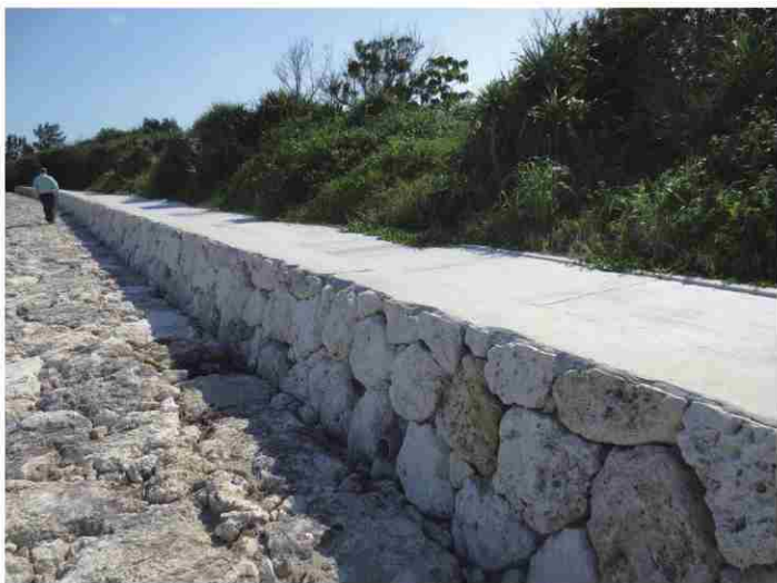
海岸保全施設整備事業 北浜地区
