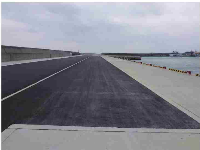
水産流通基盤整備事業 平敷屋地区
