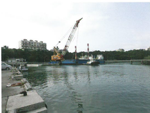
嘉手納漁港浚渫工事(災害復旧事業)
