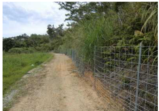
イノシシ侵入防止柵
