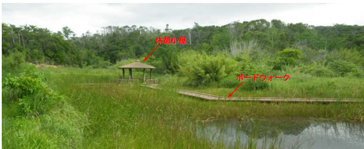
図 3.4.4 整備例② 漢那ダム第二貯水池（宜野座村）
