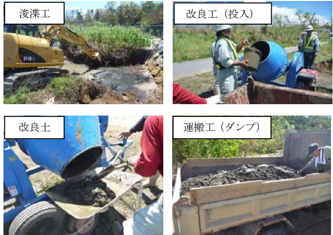
図 3 試験施工の実施状況
