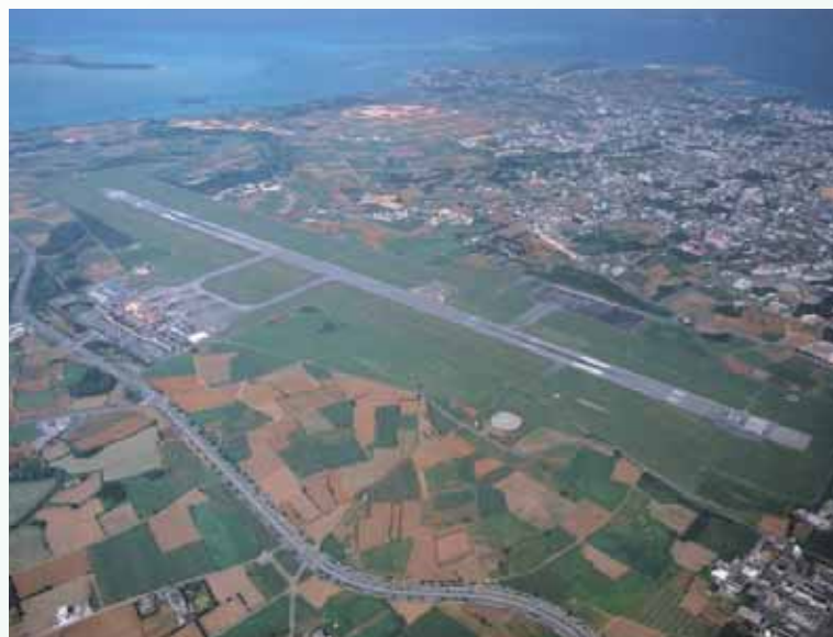
宮古空港 (全景)
