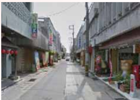
補修前(西里通り)
