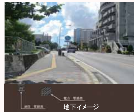
無電柱化実施後
