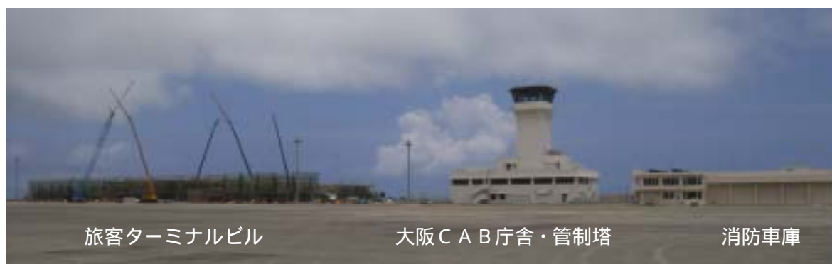
図 2.13.1 旅客ターミナルビル等建築の現況写真（平成 24 年 5 月）
