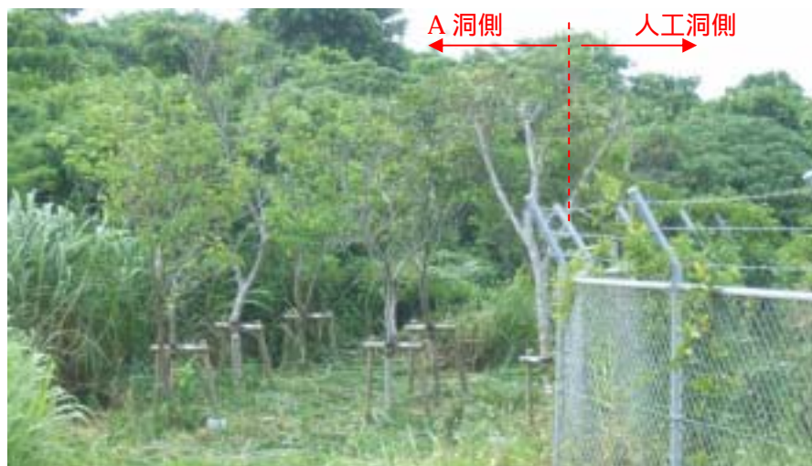
図 2.11.2 人工洞前の植栽現況（平成 24 年 5 月）
