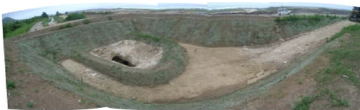
図 3.13.1 現況写真（平成 23 年 5 月）
