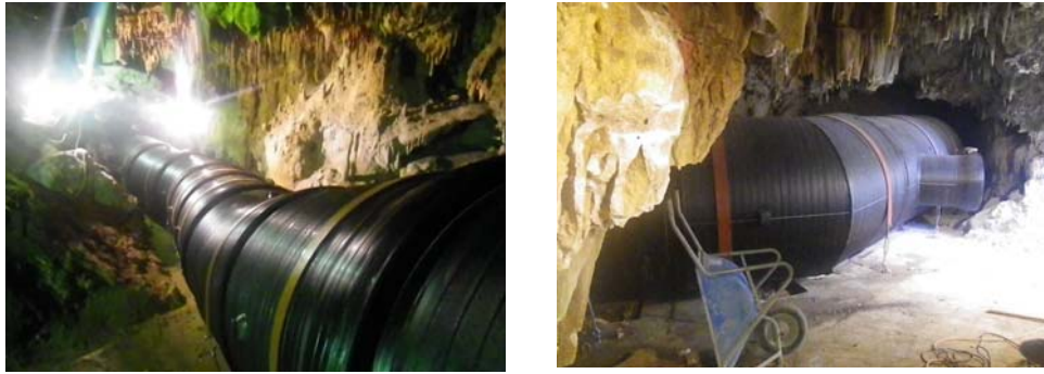
图 1.4.6 E 洞空洞对策工施工状况写真
