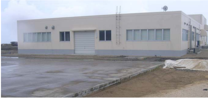
図 1.10.1 電源局舎完成状況
