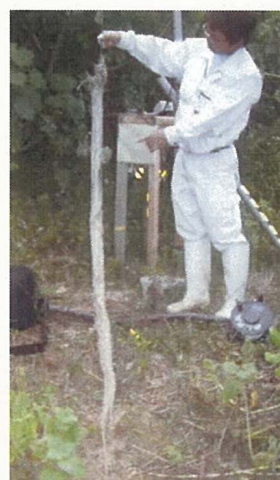
写-2 観測孔内に侵入した樹根
