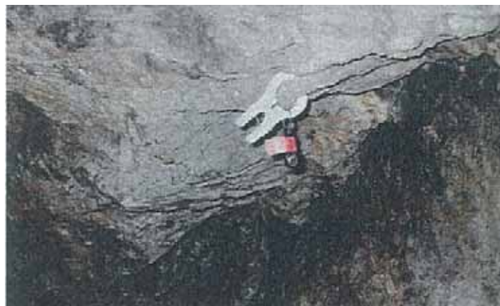
図 5.3 環境測定器設置状況
