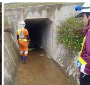
洞口の安全連絡員 (右端の作業員)
