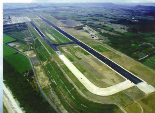
新石垣空港整備事業進捗状況【北側】(平成23年12月撮影)
