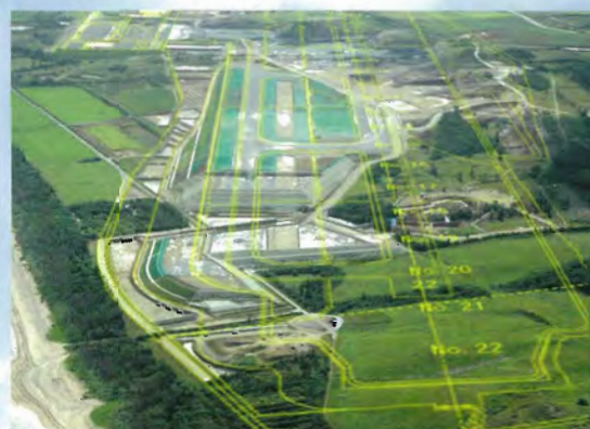
新石垣空港整備事業進捗状況【北側】(平成20年11月撮影)
