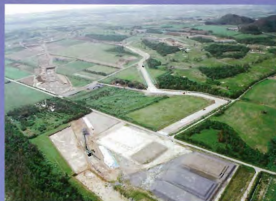
着工直後(平成19年3月撮影)
