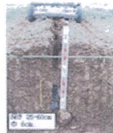
図3. 施工直後の状態
