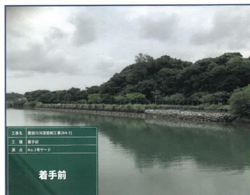
着 手 前 【No.46~No.51・3号ヤード】下流側
