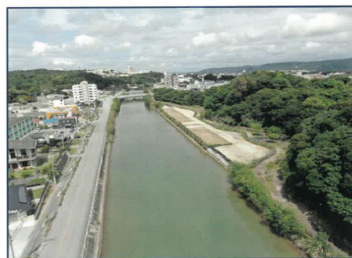
着 手 前 【No.46～No.51・3号ヤード】下流側
