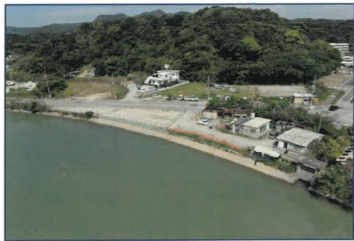
完 成 【No.77～No.83・4号ヤード】上流側
