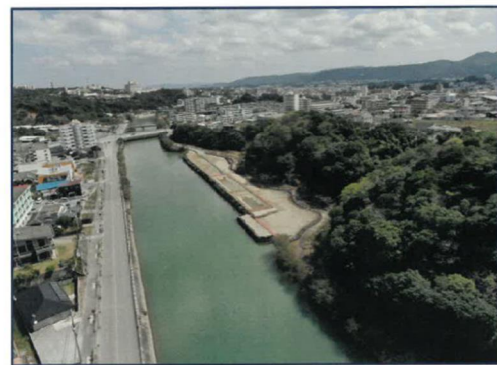
完 成 【No.46～No.51・3号ヤード】下流側
