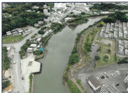
着 手 前 【No.77～No.83・4号ヤード】上流側
