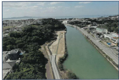
完 成 【No.46～No.51・3号ヤード】下流側
