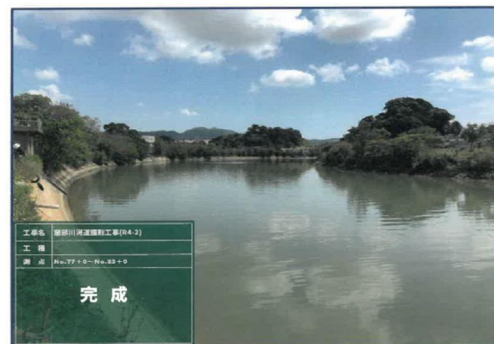
完 成 【No.77~No.83・4号ヤード】上流側
