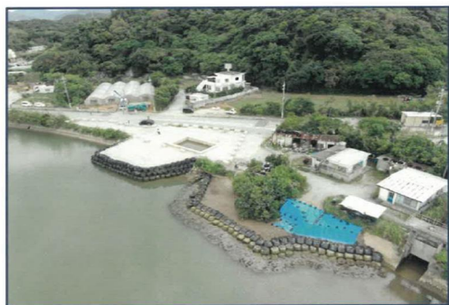
着 手 前 【No.77～No.83・4号ヤード】上流側
