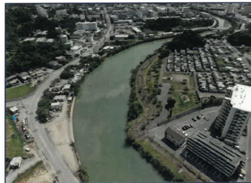
完 成 【No.77～No.83・4号ヤード】上流側
