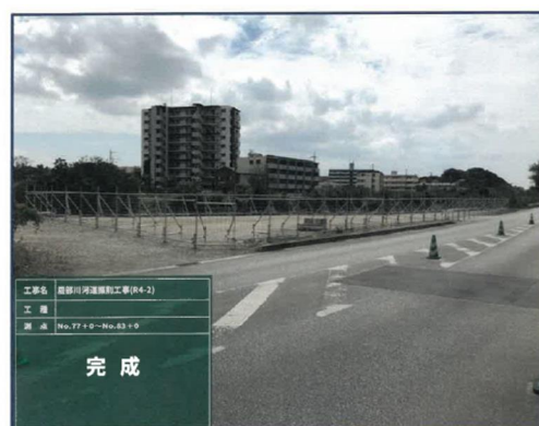
完 成 【No.77~No.83・4号ヤード】上流側
