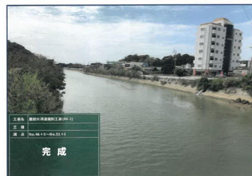
完 成 【No.46~No.51・3号ヤード】下流側
