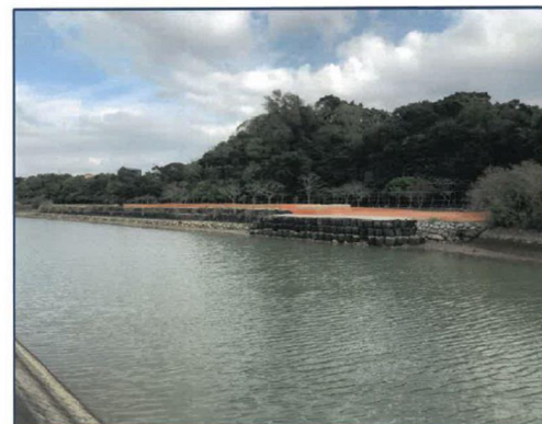
完 成 【No.46~No.51・3号ヤード】下流側
