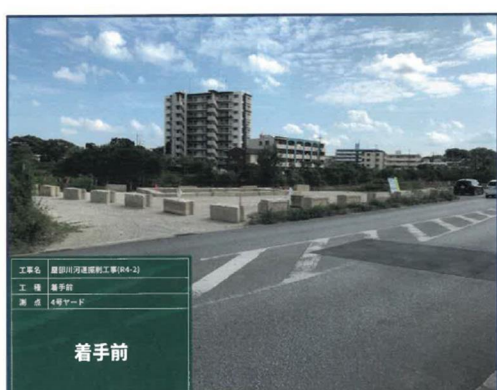
着 手 前 【No.77~No.83・4号ヤード】上流側
