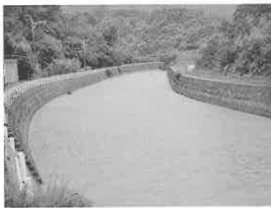
本部町大浜地区大小掘川 (川下から撮影)
