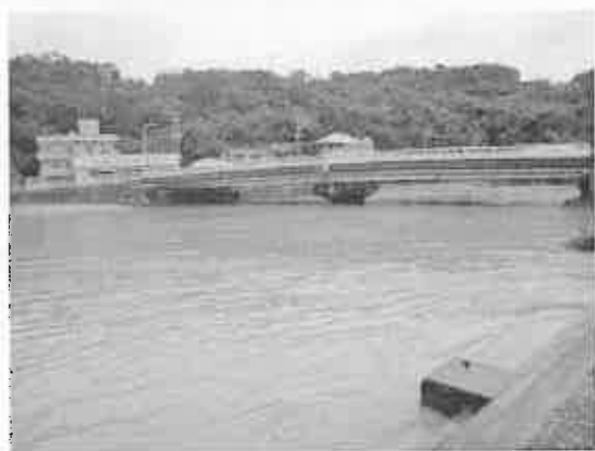
本部町渡久地港内の流出状況
