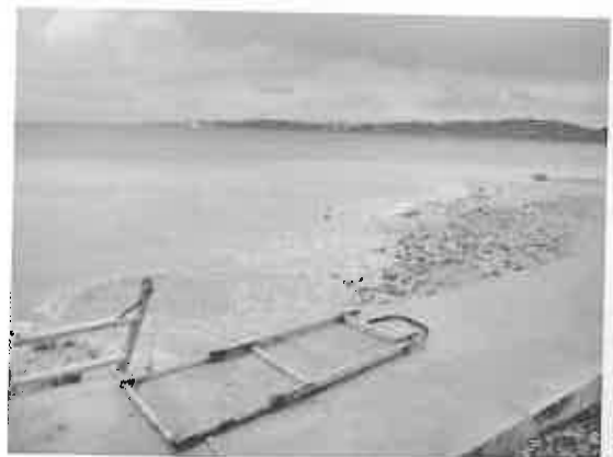
本部町崎本部地区公共工事での現場
