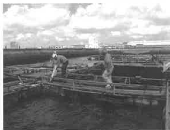
図3. 底質改善剤散布の様子
