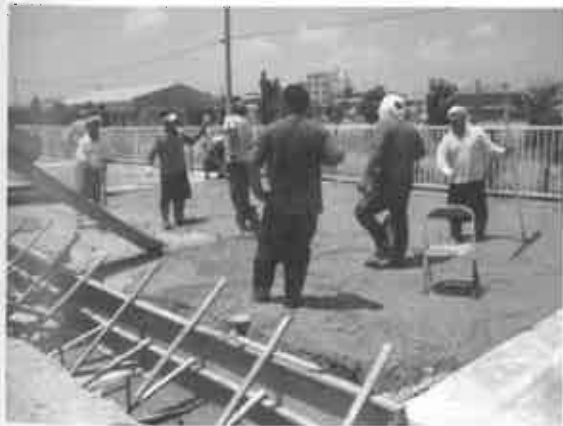
図－1 土間打ち作業
