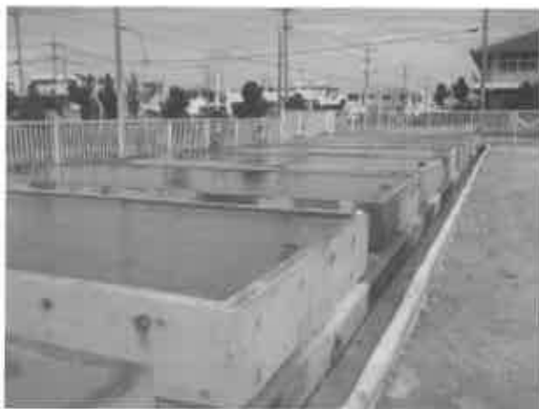
図－2 コンクリート槽アク抜き
