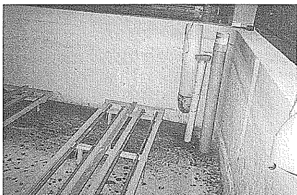
トコブシ養殖水槽の底面 エアー配管と養殖ゲージ設置台
