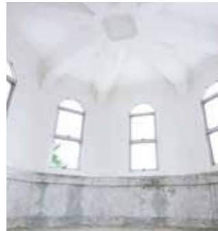
2階室内、かつての村長室です。全方向に窓があり、景色が見渡せます。
