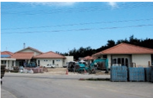
建設中の公営宿泊施設「夢パティオたらま」（仮称）
