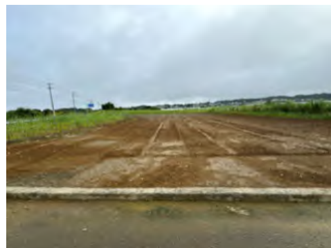
対策未実施例 地点No.268
