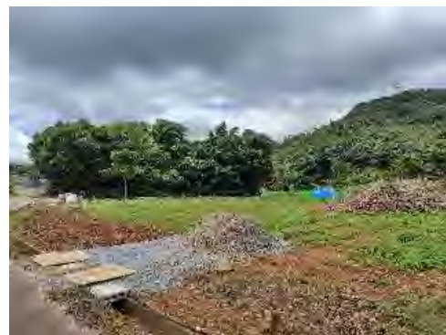
対策未実施例 地点No.68
