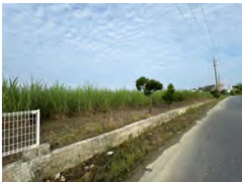
対策実施例(ブロック等) 地点No.155
