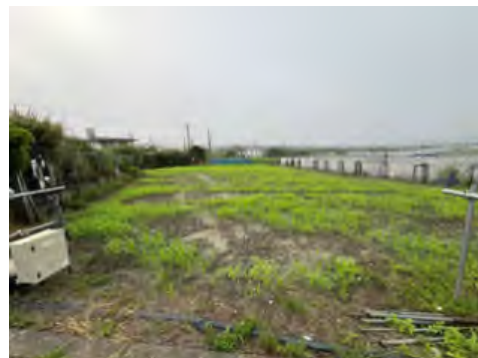
対策未実施例 地点No.230
