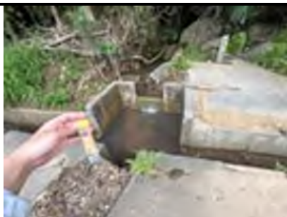
山間部からの流出確認
