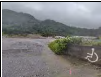
a. 残土置き場から流出する濁水
