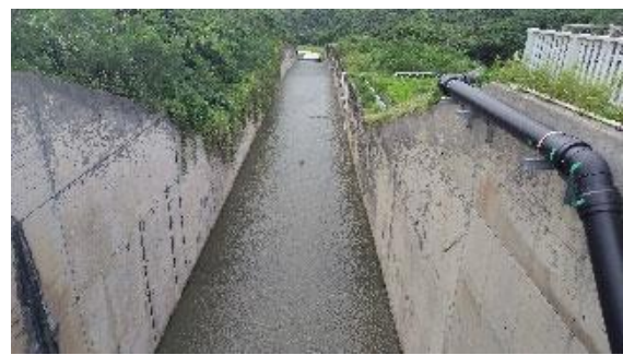
真栄里ダムの状況（宮良湾）
