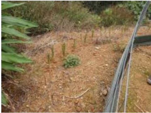
対策実施例（グリーンベルト補栽） 地点No3 8
