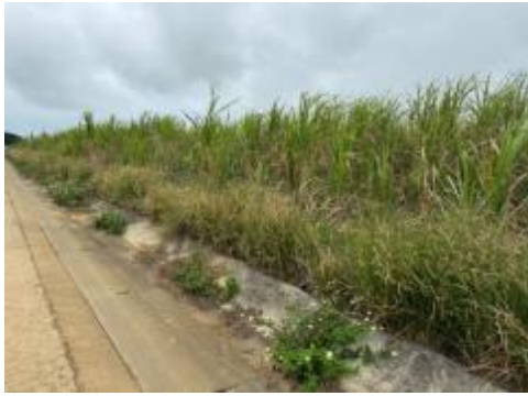
対策実施例（グリーンベルト補栽） 地点No.7 8
