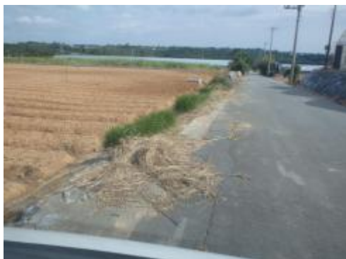
対策実施例（グリーンベルト補栽） 地点No.1 7
