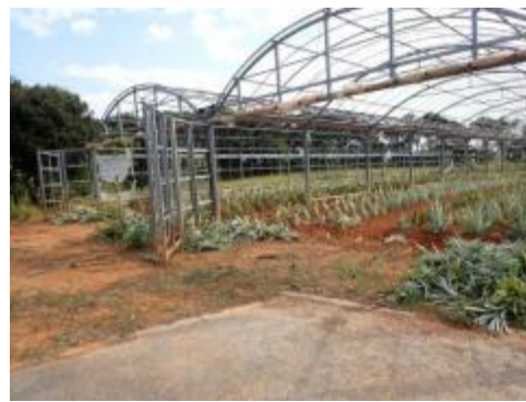
対策未実施例 地点No7 5
