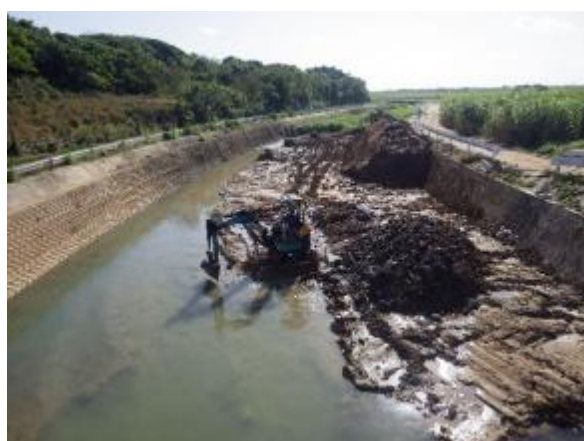
轟川観測地点上流側での浚渫状況と下流側の汚濁防止膜
