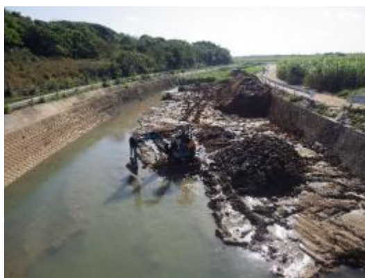
下流地点上流側での浚渫の様子
