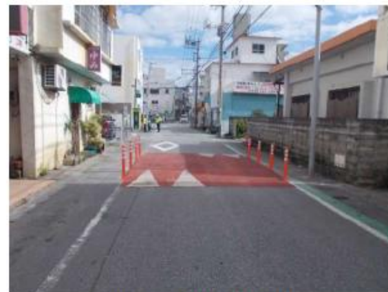
ハンプ設置状況
