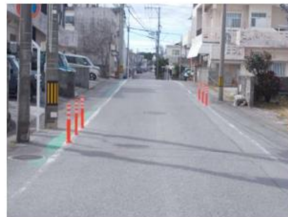
狭さく設置状況
