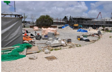
調査箇所 (南西から)
