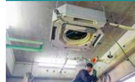
業務用冷房機取付
