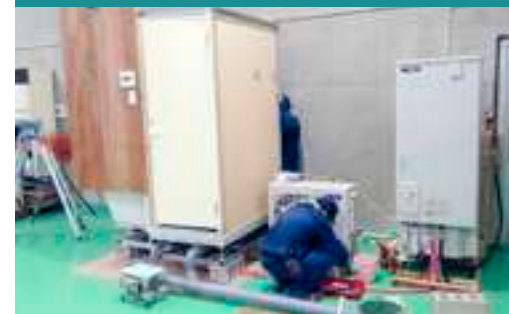
エコキュート配管施工実習
