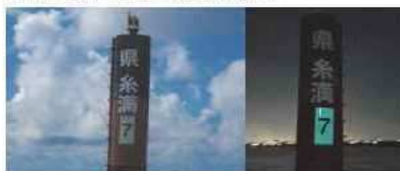
蓄光板設置後の様子
