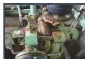
老朽化した農業水利施設
