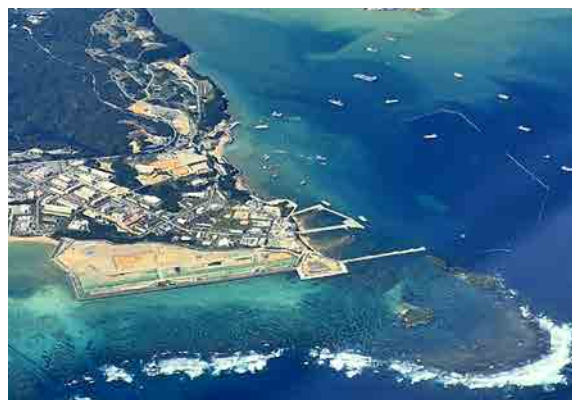
大浦湾側の土砂投入開始 令和7年(2025年)11月
