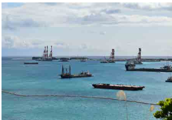
辺野古埋立て7万本杭打ち開始後 令和7年(2025年)
