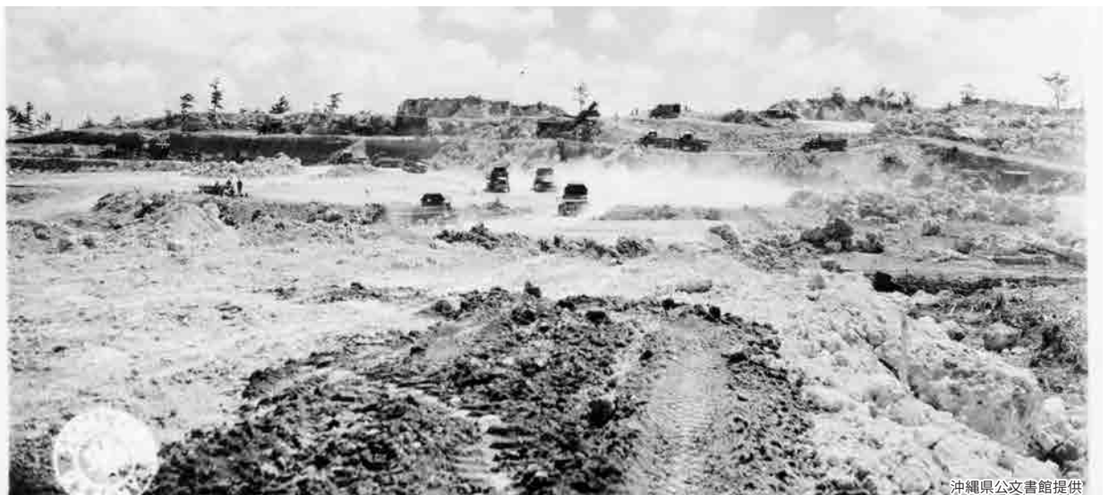
普天間飛行場の建設(現・宜野湾市) 昭和20年(1945年)
