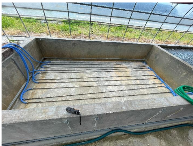
図 1 水槽底面に設置したチタン管
