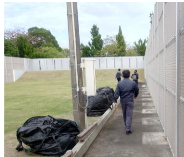
遠的場の矢取道は屋根がない
