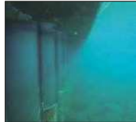
腐食部分を補修し ペトロラタム被覆に
