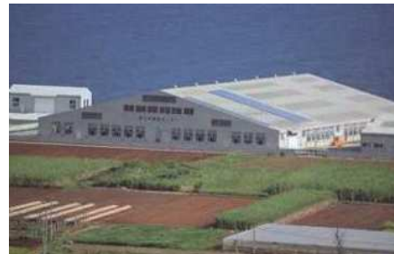
農村集落基盤・再編整備事業 (地域資源活用施設整備)
