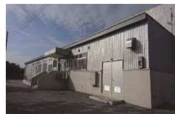
冷蔵配送センター施設 (平成27年度竣工)
