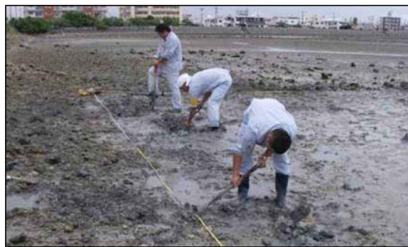
図 5-14 泡瀬地区の底質改良工の実施 12
