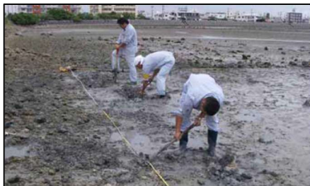
図 5-2 底質改良工(泡瀬地区)
