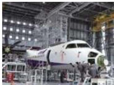
航空機整備施設
