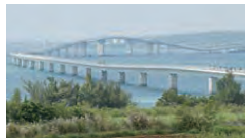
伊良部島と宮古島を結ぶ伊良部大橋開通 (平成27年12月31日沖縄タイムス)
