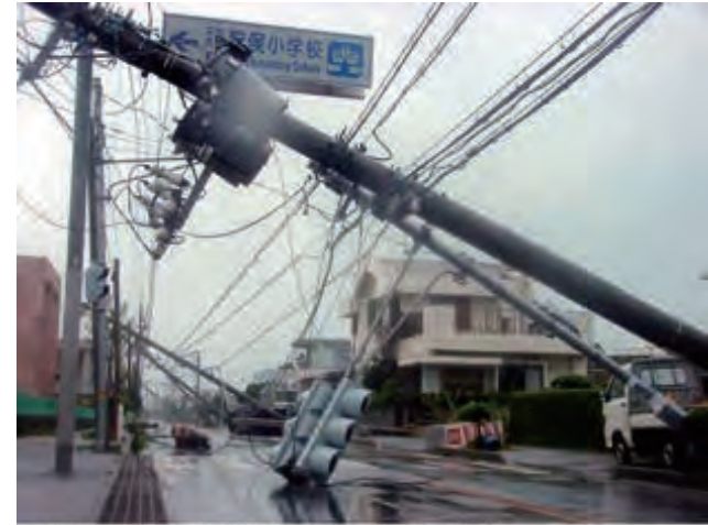
倒壊した電柱。最大瞬間風速は74.1m、被害総額は約133億円に上った。 （平成15年12月24日琉球新報）
