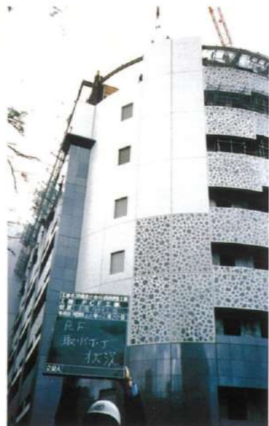
↑PCF取り付け工事
