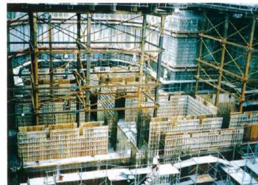
↓型枠工事（昭和63年2月）
