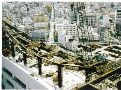
↑船型をした塔屋の鉄骨工事（平成元年6月）
