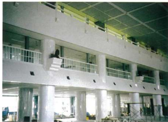
←県民ホールの内装石工事（平成元年10月）
