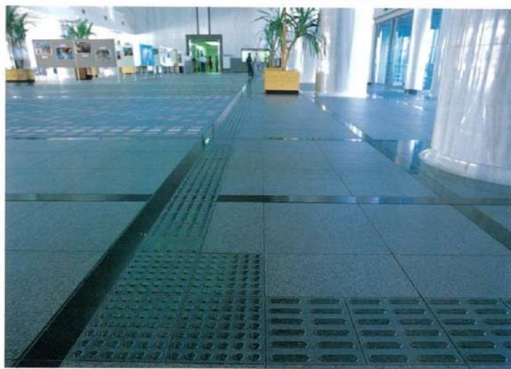
↑ 総合案内所に通ずる点字ブロック
