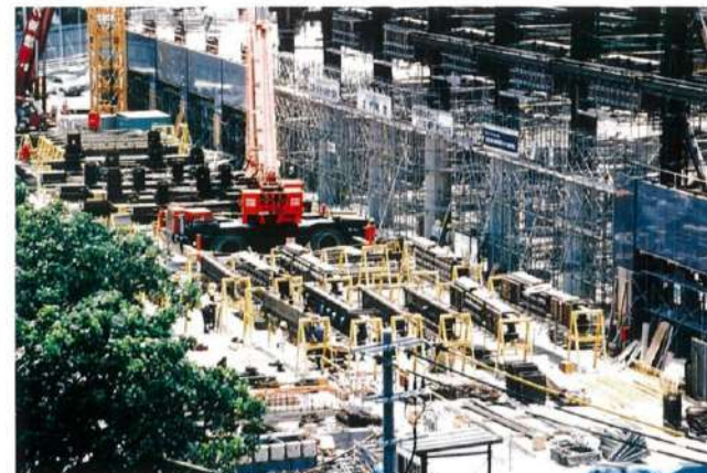
↑型枠鉄筋工事（昭和63年7月）
