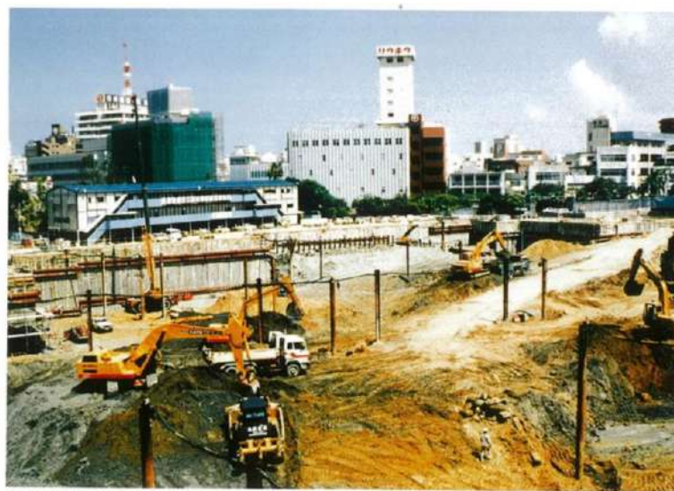
↑工事再開（昭和62年8月）
