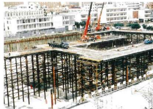
↑桟橋工事（昭和62年11月）
