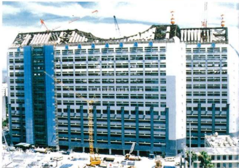
↑塔屋部分の工事（平成元年6月）
