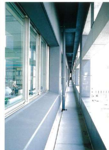
↑ バルコニー（避難外廊）
