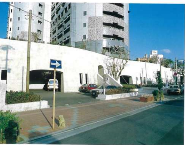
↑ 首里城の城壁をイメージした西側囲い
