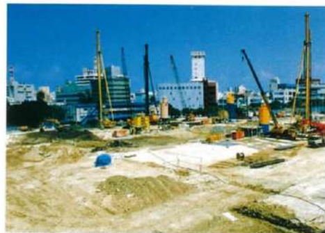
↑工事が始まった現場（昭和61年9月）
