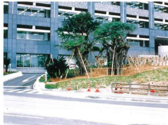
↑北側方面の植栽工事（平成元年11月）
