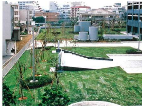
↑南側の植栽工事（平成元年11月）
