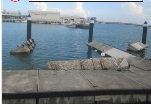
① 台風時の浮桟橋被災状況
