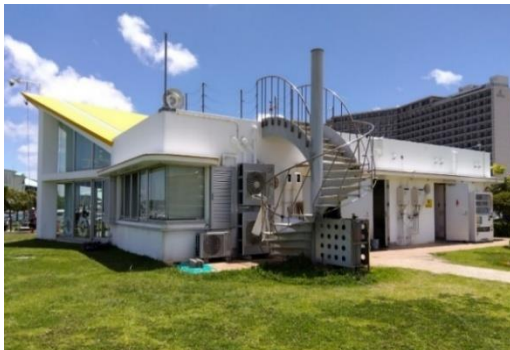
管理棟（事務室、シャワー、トイレ）
