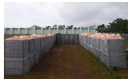
施設訓練（陣地構築訓練）
