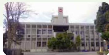
沖縄県動物愛護管理センター 譲渡推進棟
